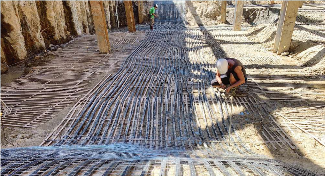
將捷之森地緣管路施作
