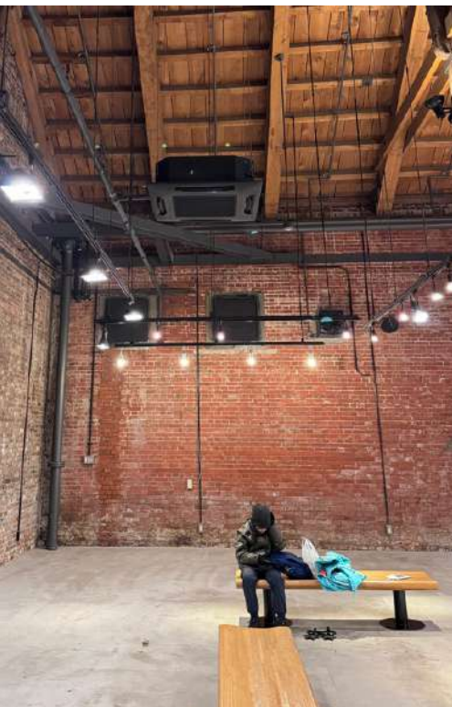
4.金森倉庫內部紅磚牆與木樑之保存
