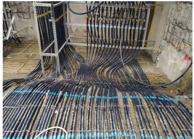
民富案地源管路預埋
